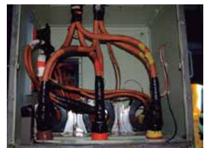
Fig.13 Motor Terminal Box depois da instalação do MSIM
