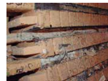
Fig.5 Exemplo de um estator em falha em um motor de 12.000 HP, AC, 13,8 kV. Motor industrial usado em um refinador num moinho de papel.
